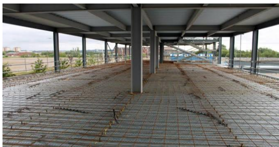
Gambar 8 Pembesian Pelat Lantai
