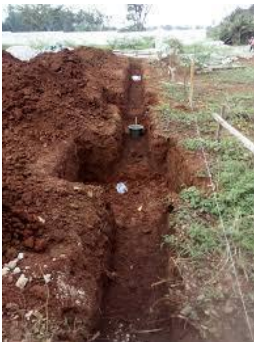
Gambar 6 Pekerjaan Galian Footplat
