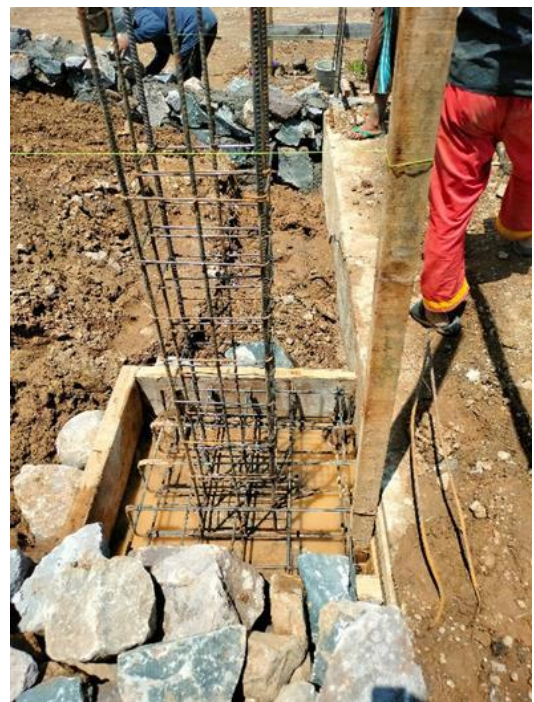
Gambar 7 Pembesian Footplat
