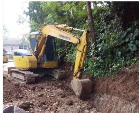
Gambar 4 Pekerjaan Galian Saluran Drainase
